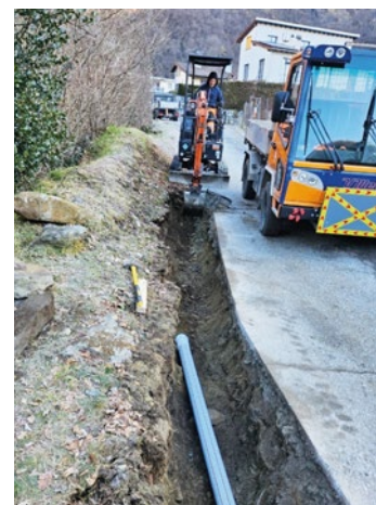
Lavori di posa delle infrastrutture per l'illuminazione pubblica eseguite dalla nostra squadra esterna
